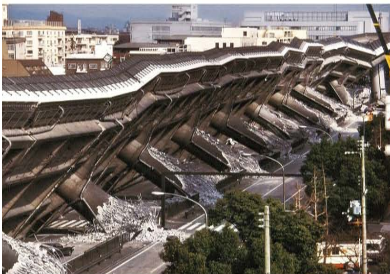
Angriff auf die Lebensadern Im Januar 1995 legt ein verheerendes Beben diese Straßenbrücke und Zehntausende Bauten der japanischen Stadt Kobe in Trümmer
